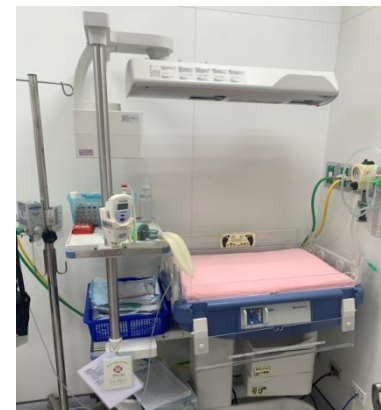
設置新生兒處理台
